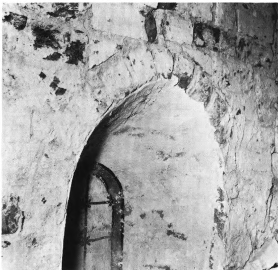
Fig. 5. Detalje af vindue i den o. 1250-1350 ombyggede vestgavl (s. 1245): Den indre åbnings øvre del med kalkmalet vinduesramme (s. 1255) på den ved tårnets opførelse blændede lysning. EIM fot. 1961. - Detail of a window in the west gable rebuilt c. 1250-1350: upper part of the inner splay with the fragment of a mural showing a window-frame on the bricked up light (sealed off when the tower was built).
